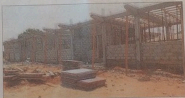
Inzwischen investiert der Staat in die Schule in Sukuta. Es werden 18 neue Klassenräume gebaut.
